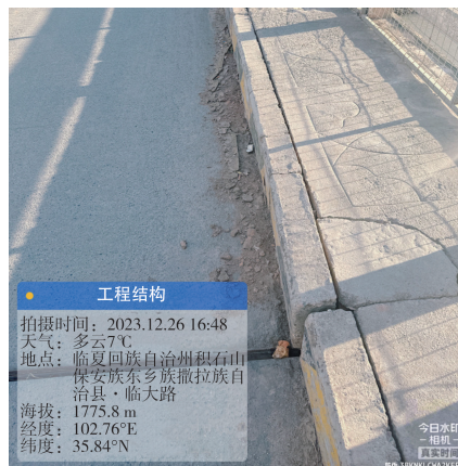
图 13 跨中挂梁横向侧移
