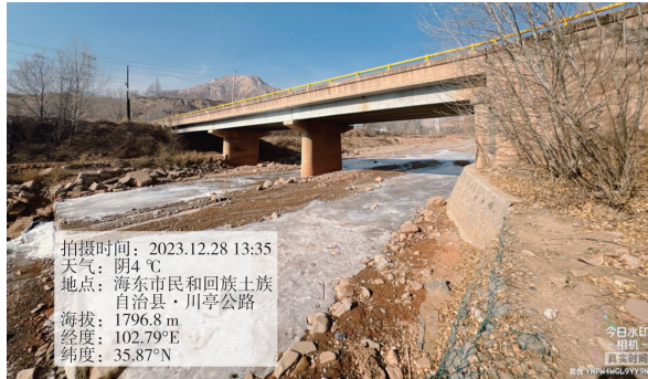
图 20 川亭公路通往官亭镇的公路桥梁
