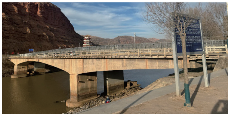
图 11 大河家黄河大桥旧桥
