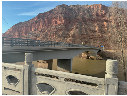
图1 大河家黄河大桥(新桥)
