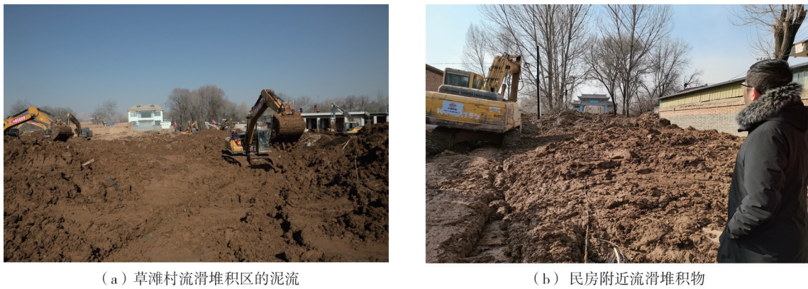
图 1 中川乡流滑堆积区泥流混合物及清理情况
