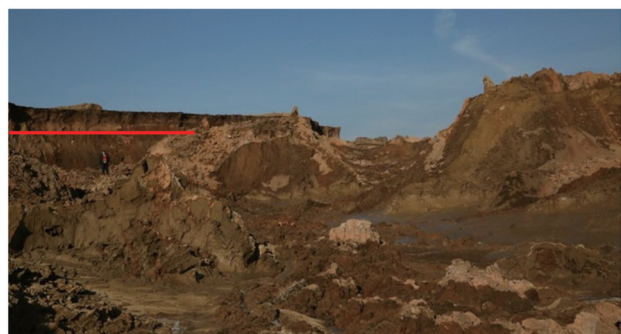
图 8 流滑区的土层剖面以及初步确定的液化土层
