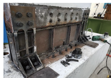
图8 试件 RPSW-SE 修复过程
