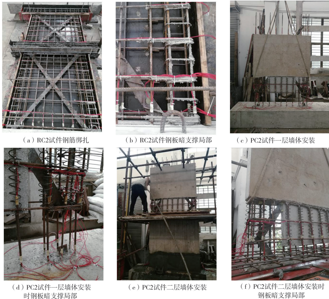
图2 试件制作现场
