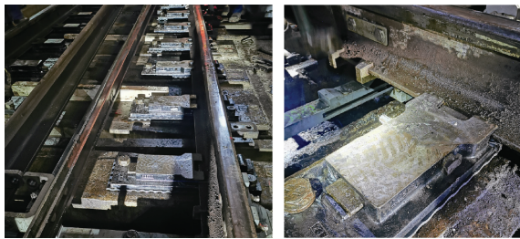
图9 整铸滑床板现场铺设
