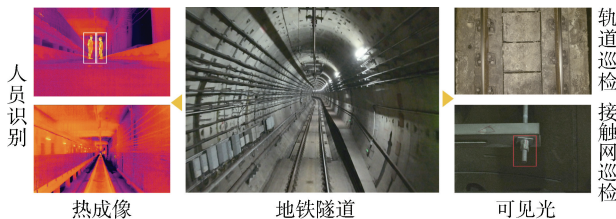
图 4 轨道交通隧道巡检
