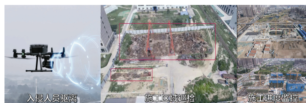
图 2 施工范围监控
