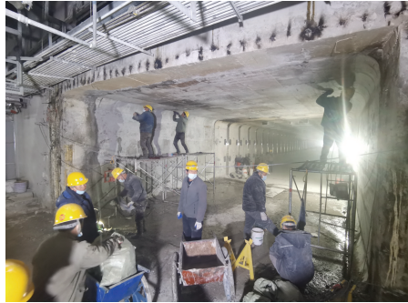
图 9 弃壳接收现浇段贯通
