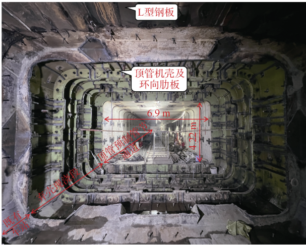
图 8 顶管弃壳接收施工(车站方向)
