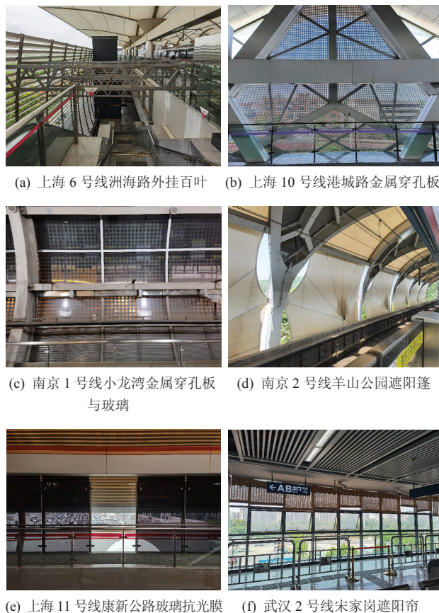
图 14 常见的高架地铁车站遮阳形式 Figure 14 Common shading types for elevated subway stations
