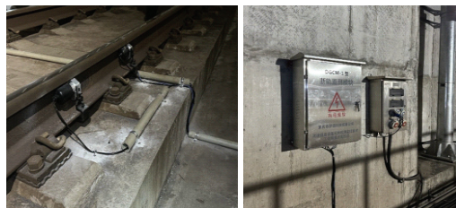
图 4 现场设备安装
