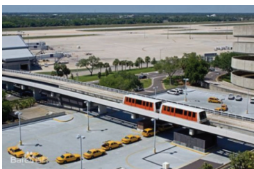
图 6 坦帕国际机场的 APM 系统
