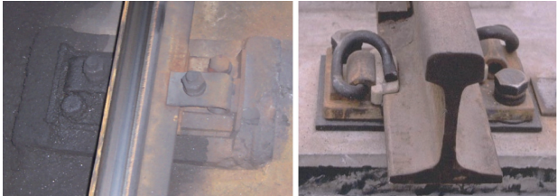
(a) DT I 型扣件 (b) DTVI2 型扣件
