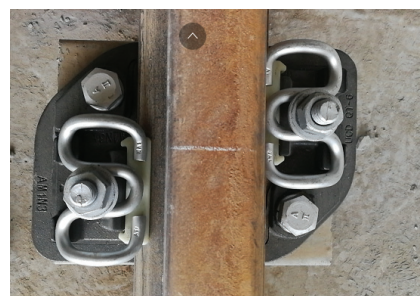
图 6 嵌套式高弹性减振扣件
