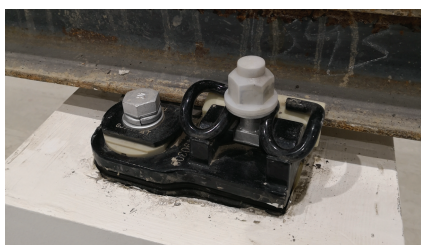
图 5 双层非线性压缩型减振扣件
