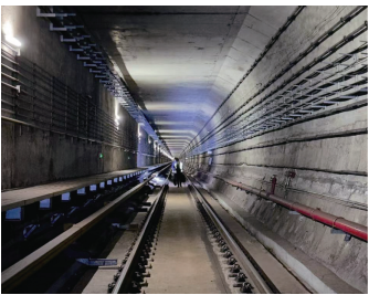
图 3 现场测试场景
