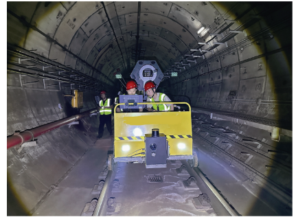
图 12 现场作业照片
