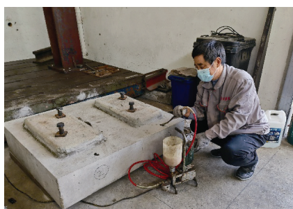
图4 现场带压灌注施工
