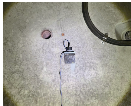
图 1 现场测试照片
