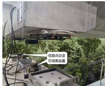
图 15 盖梁顶可调高装置布设
