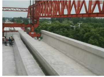
图 14 梁体架设试验梁(右侧梁体)
