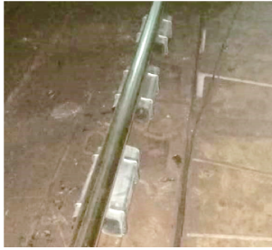
图2 钢轨阻尼装置安装试验段
