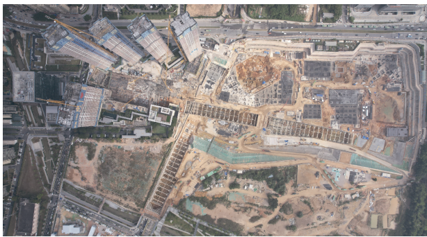
图 4 轨道与地块建设航拍
