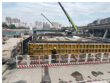
图 7 现场管节钢筋笼入模
