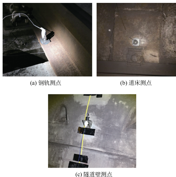
图1 隧道内振动测点布置
