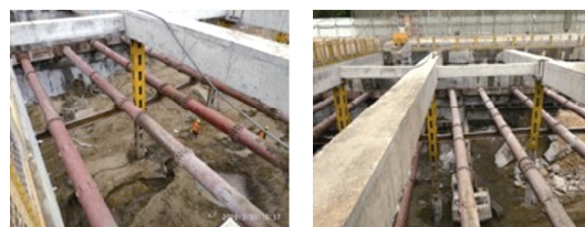
(b) 基坑工程的施工情况
