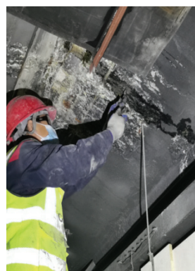
图7 区间渗漏现场应急处置
