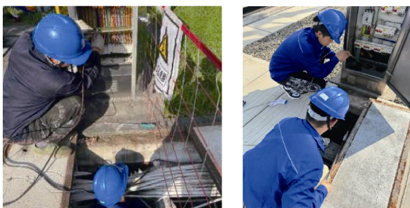
(a) 人工穿引线 (b) 本文设计机构穿引线
