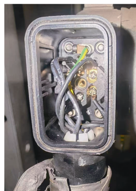
图 3 SF 6 表计接线盒内部接线
