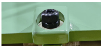
图11 改进后的拉带紧固螺母
