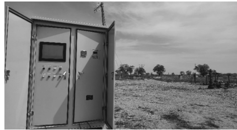
图11 同井采注系统应用现场
