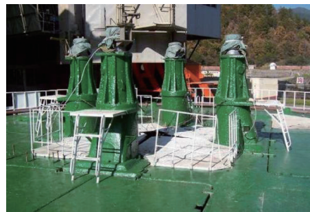
图2 长征三号发射台热防护施工后
