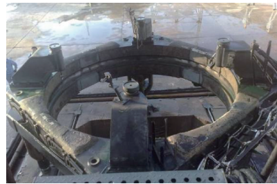
图8 火箭发动机燃气流烧蚀后的发射台表面
