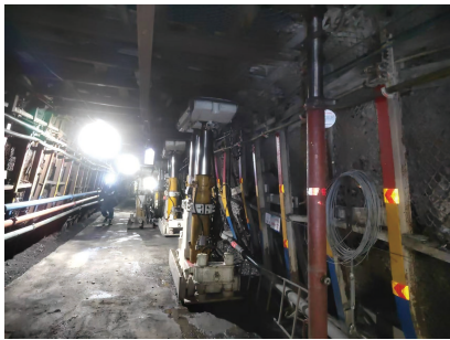
图 25 试验段巷道现场支护效果
