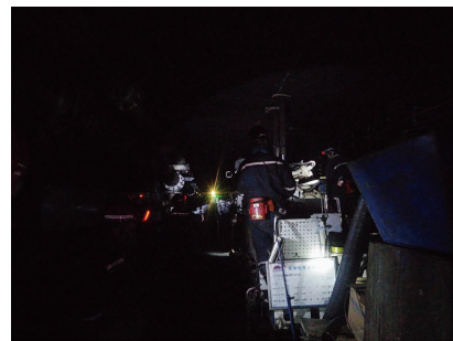
(a) 钻孔施工
