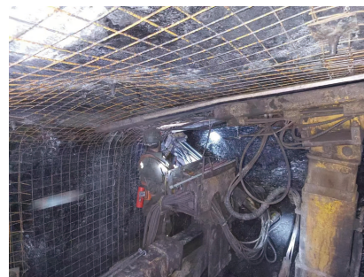
(b) 加强锚索施工
