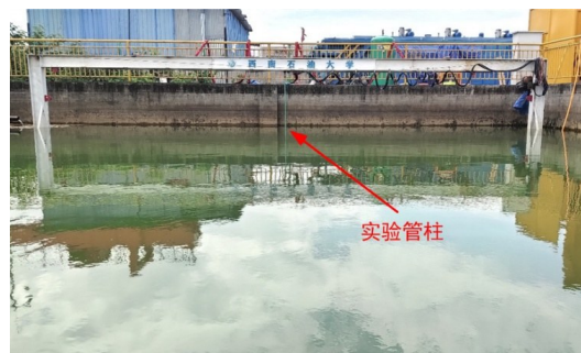
(b) 实验现场实物图
