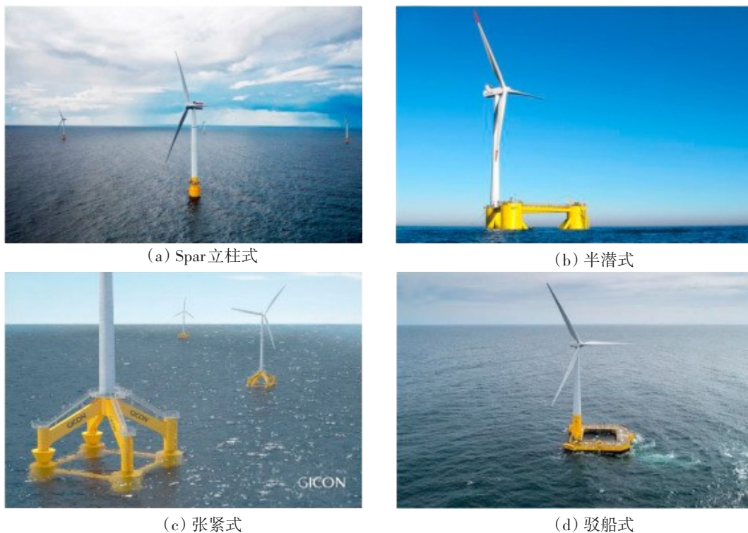
图 6 目前主流的几类系泊漂浮风机基础 [32]
