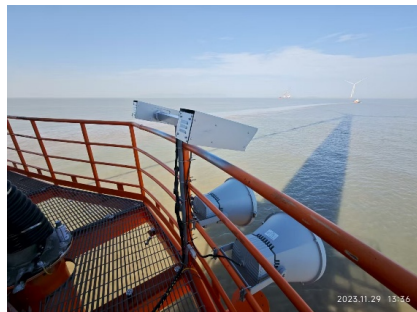
图9 海上固定式风机安装的双目视觉测波系统
