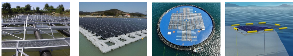
(a) HDPE浮管和铝材组合式 (b) 纯浮块连接式 (c) 薄膜垫式 (d) 沉没式
