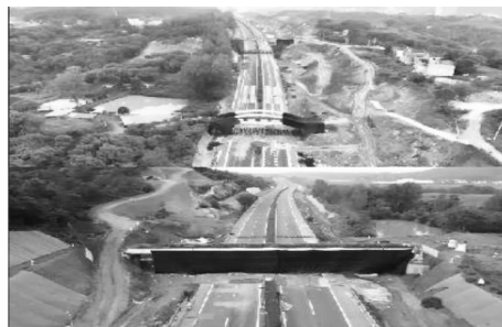
图9 爆破个别飞散物防护图
