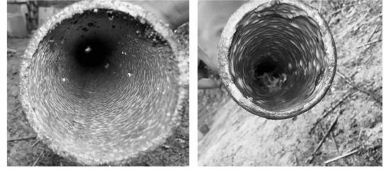
图 4 管壁残留乳化炸药
