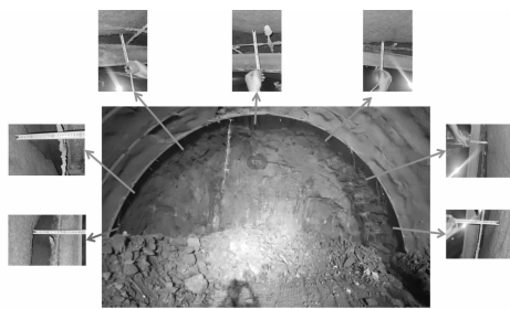
(a) 现场超挖测量图
