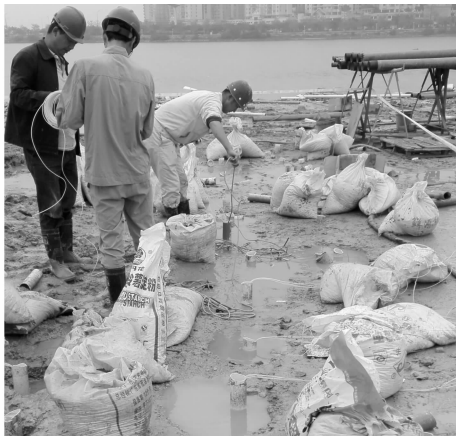
图2 爆破现场装药图
