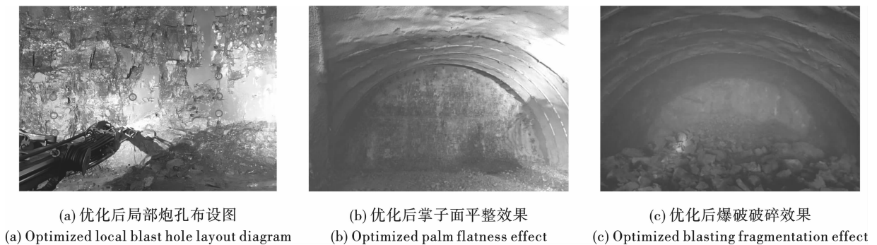
图 13 优化后隧道爆破效果图
