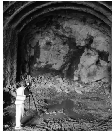
图3 隧洞轮廓激光扫描测量
