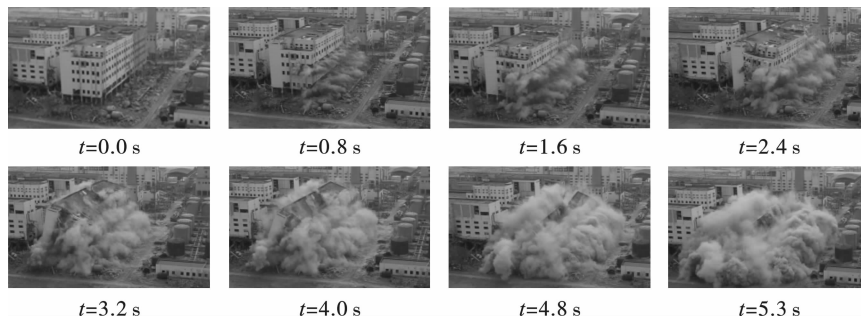
图 5 结构车间倒塌过程
