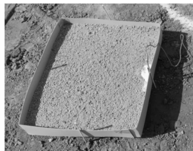
图 6 2# 试板现场安装图
