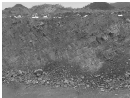
图1 现场岩体结构
