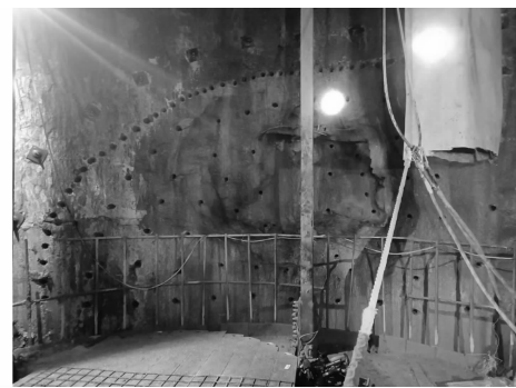
图 4 炮孔施工完成图
