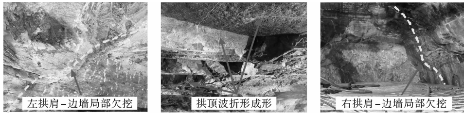
图5 光面爆破后轮廓围岩不规则成形
