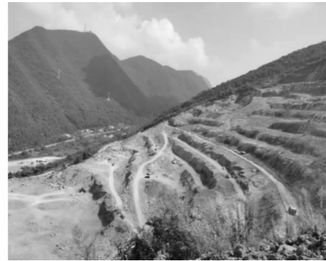
图 1 塘垭水泥灰岩矿露天边坡图
