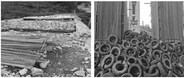
图 5 爆破防护照片
