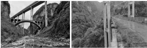
图2 新桥与石拱桥位置实景照片
