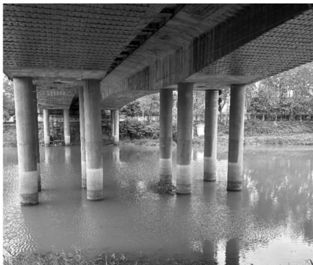
图 4 粘贴钢板加固
