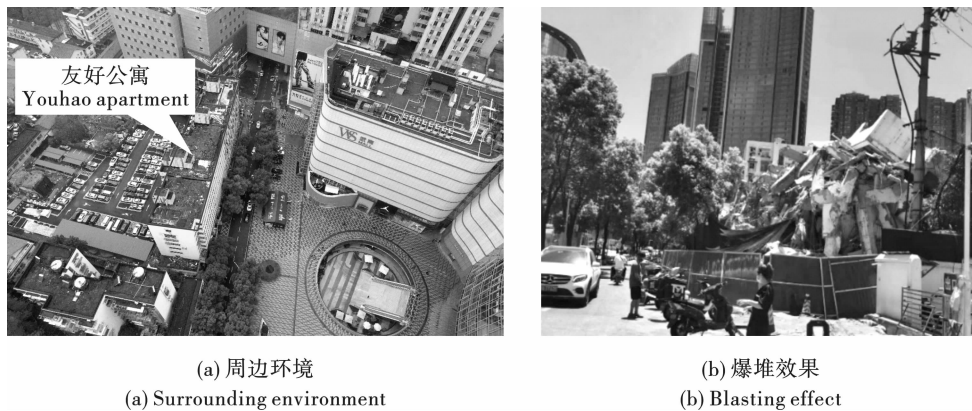
图9 友好公寓爆破拆除工程
