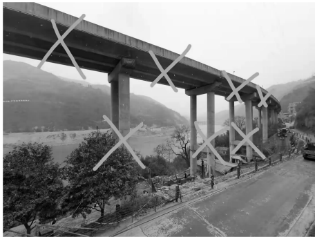
图 1 需爆破拆除部分桥跨实景图
