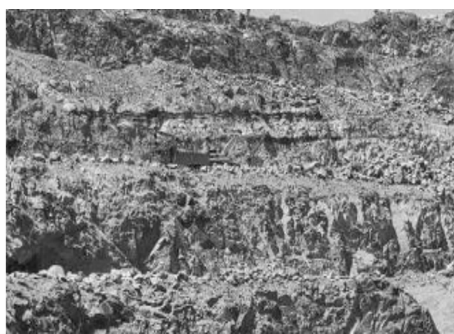
图2 人工和机械清理平台浮石
